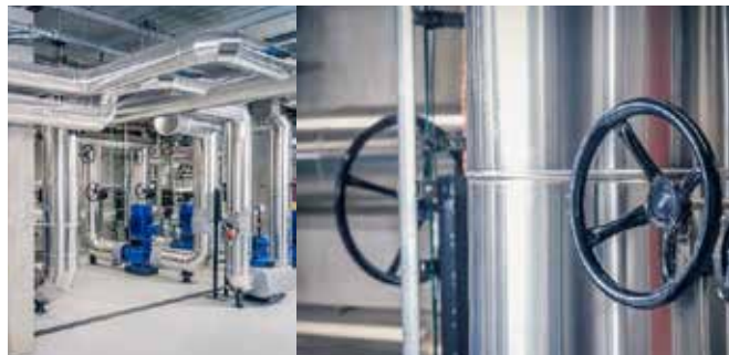
Robinet à tournant sphérique BROEN Ballomax® qui contrôlent le débit d'eau du chauffage urbain - combinant deux vannes dans un même puits.
